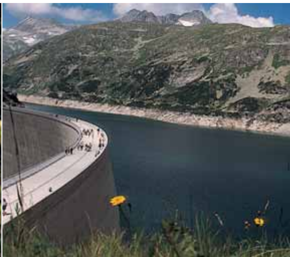
Kölnbreinsperre , ganz oben im Maltatal
